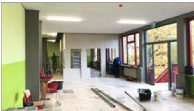
Abb. 9: Einbau der LernBOX in den Schulflur 11/2020
