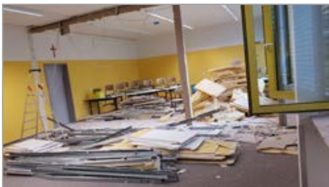
Abb. 2: Start der Umbaumaßnahme 01/2019
