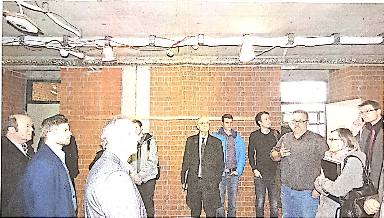
Der Kreistag-Ausschuss für Bau und Verkehr besichtigte die Hofheimer Realschule. An dem Gebäude sind Sanierungsarbeiten erforderlich. An den Decken wurde bereits mit den Baumaßnahmen begonnen. Eva Mangold (Zweite von rechts) erläuterte die Details der Planung. Fotos: Christian Licha
